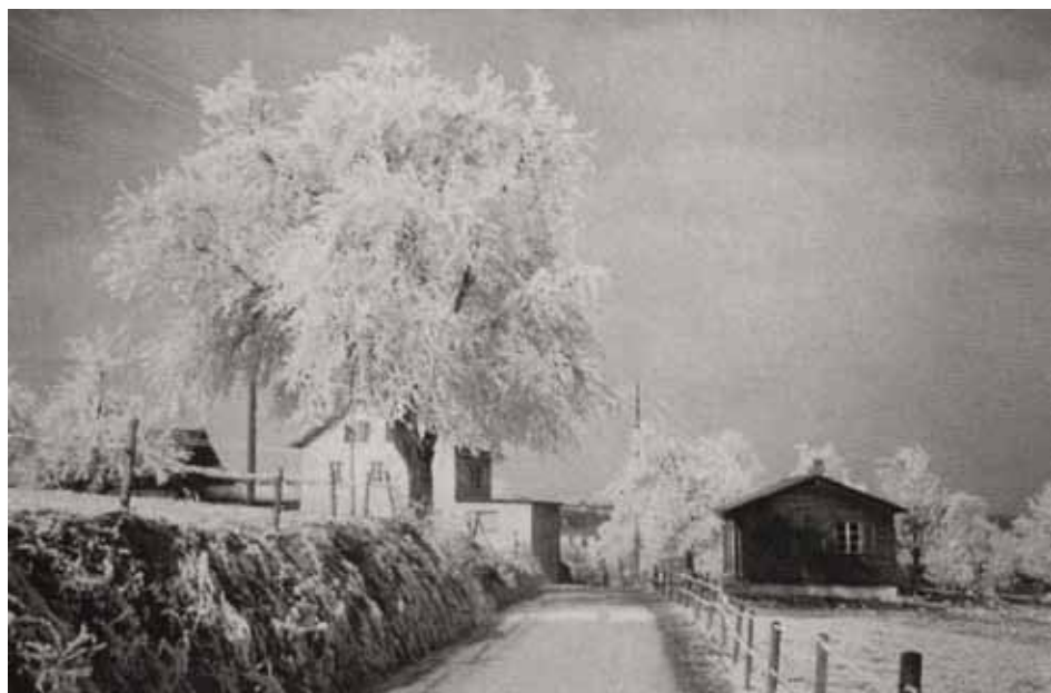
Die Depot-Baracke an der Unterdorfstrasse im Jahre 1944.
