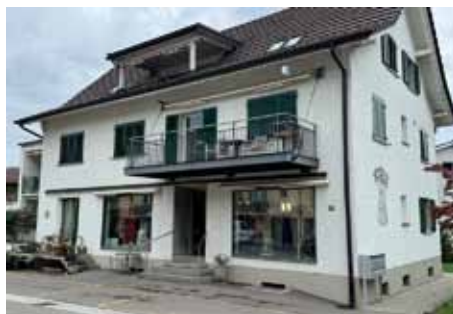
Das Atelier an der Unterdorfstrasse 25 in der ehemaligen «Gnossi».
