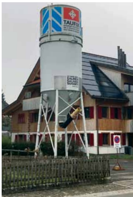
Das Streusalz-Silo an der Unterdorfstrasse.
